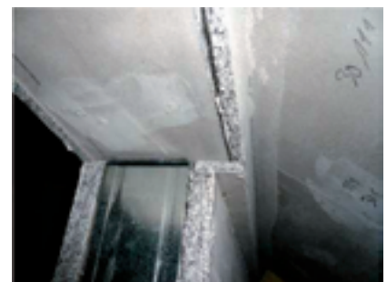
Bild 1: Doppelte Beplankung im Übergang WC-Wand zur Mittelfette; die dunklen Sprengel im Querschnitt zeigen die Graphitanteile
